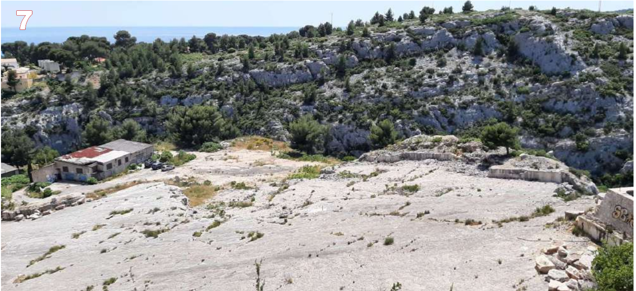
7 Vue sur le site du projet immobilier et le ravin du Vallat des Brayes depuis le bord du front de taille de l'ancienne carrière.
