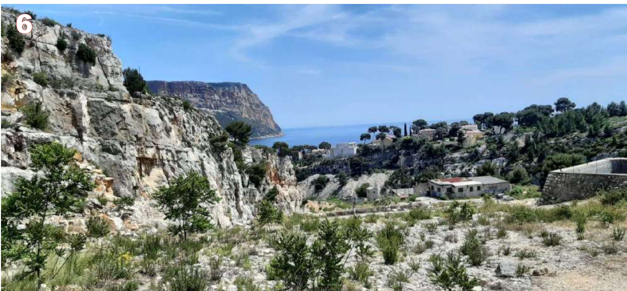
Vue depuis le haut du projet, en direction de la baie de Cassis. Au premier plan, se situent les parkings de l'hôtel et la voie pompier
