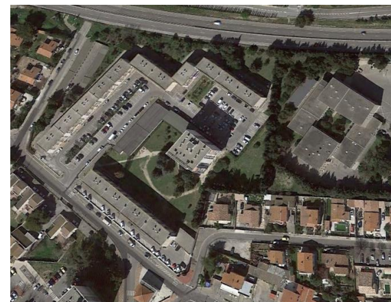
Exemple de toitures favorables sur le secteur Les Horizons de la Mer de Port-de-Bouc
