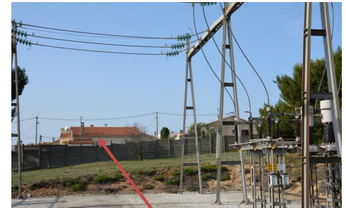
Grande toiture d'habitations subissant la nidification des Goélands
