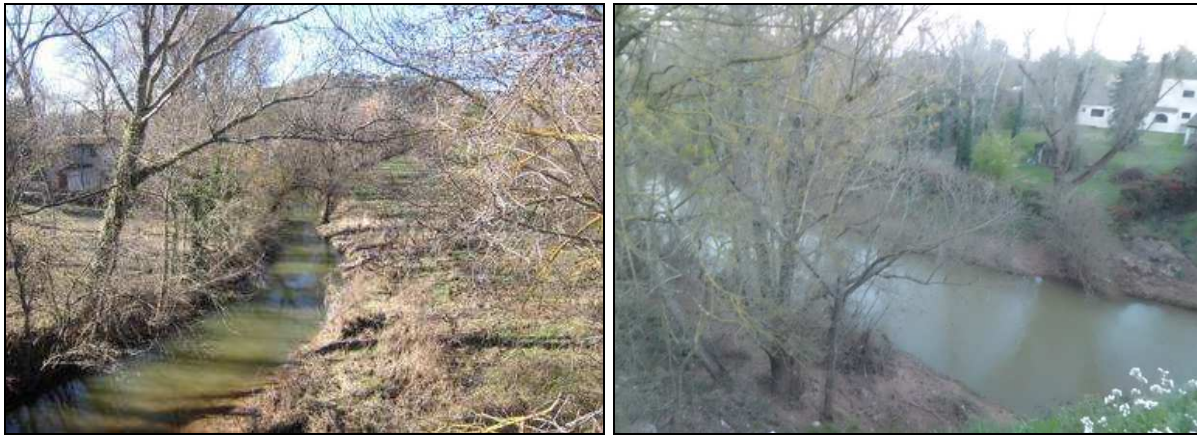
Photos à Fuveau : gauche : l'Arc en aval du pont des Bachassons – droite : habitation de lieu dit La Barque à proximité du lit mineur
