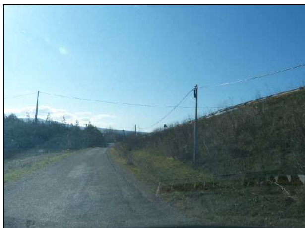
Figure 7 : Exemple de talus routier (A8 à Trets)
