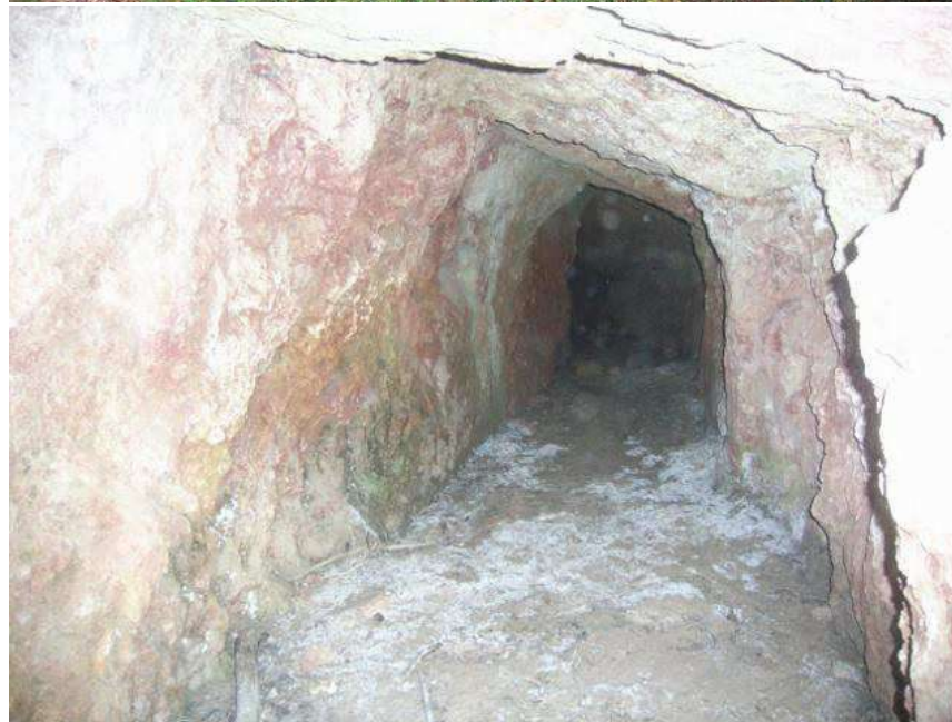
Vue intérieure d'une galerie sur le secteur de Manville Ouest au sud la commune des Baux-de-Provence © GEODERIS
