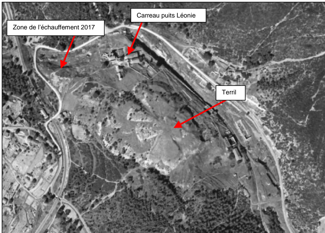
Figure 3 : Carreau et terril du puits Léonie en 1949 (photographie source IGN)
