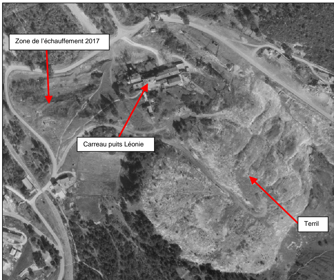
Figure 4 : Carreau et terril du puits Léonie en 1961 (photographie source IGN)
