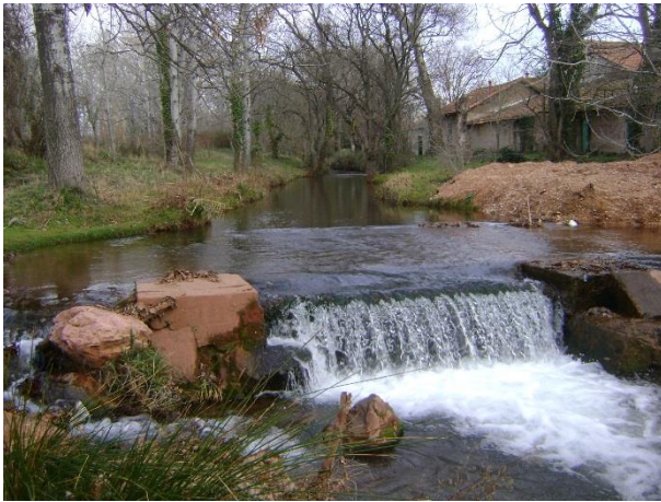
Figure 33 : Exemple d'ouvrage complexe – seuil (en amont de la traversée de la Cadière par la voie ferrée)
