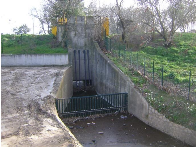
L'ouvrage en sortie du Bassin du Griffon
