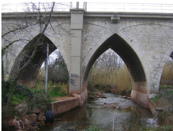
Figure 31 : Exemple d'un ouvrage de franchissement (traversée de la Cadière par la voie ferrée)
