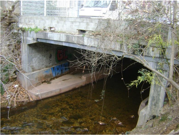
Sortie de la partie enterrée
