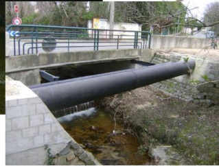
Figure 4 : Exemple d'ouvrage de franchissement
