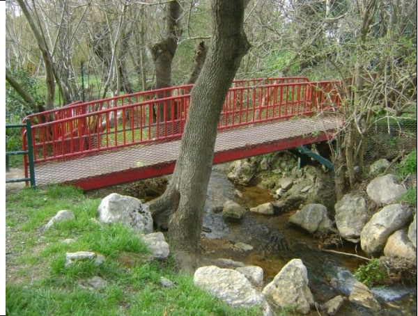
Passerelle vers air de jeux
