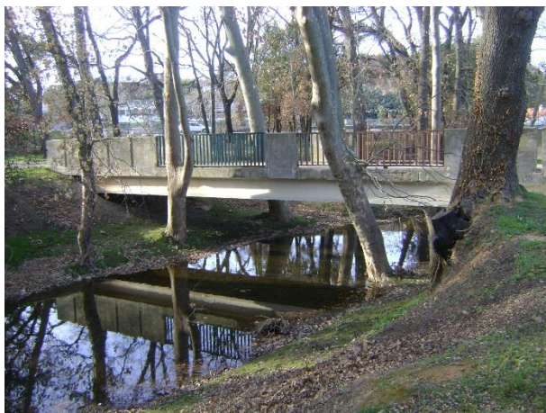
Figure 30 : Exemple d'un pont cadre (Le Bondon dans le parc du Griffon)
