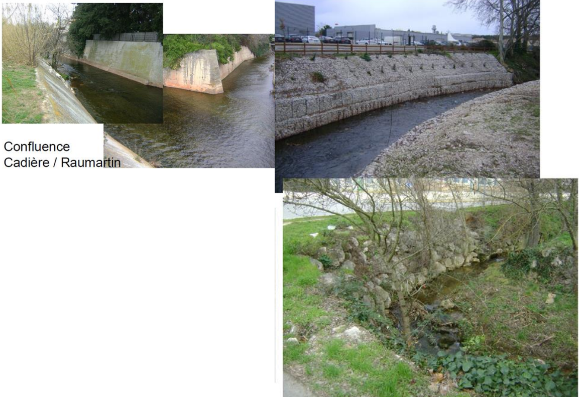
Figure 6 : Exemple de système de protection de berges
