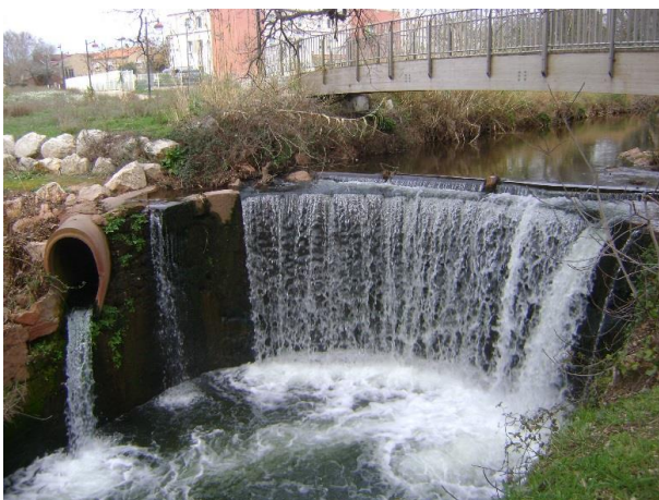
Figure 34 : La cascade sur la Cadière : un pont cadre en arrière plan et un seuil important au premier plan
