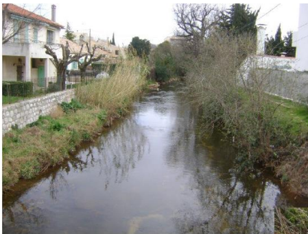
Amont couverture Cadière Zone urbaine Marignane
